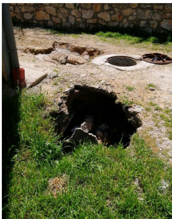
Socavón junto al pozo B
