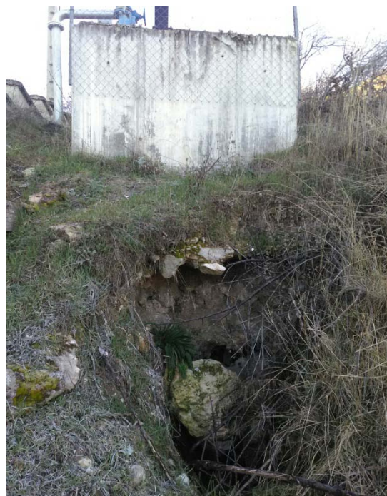
Socavón junto al Pozo B y hueco creado bajo la estación de bombeo
