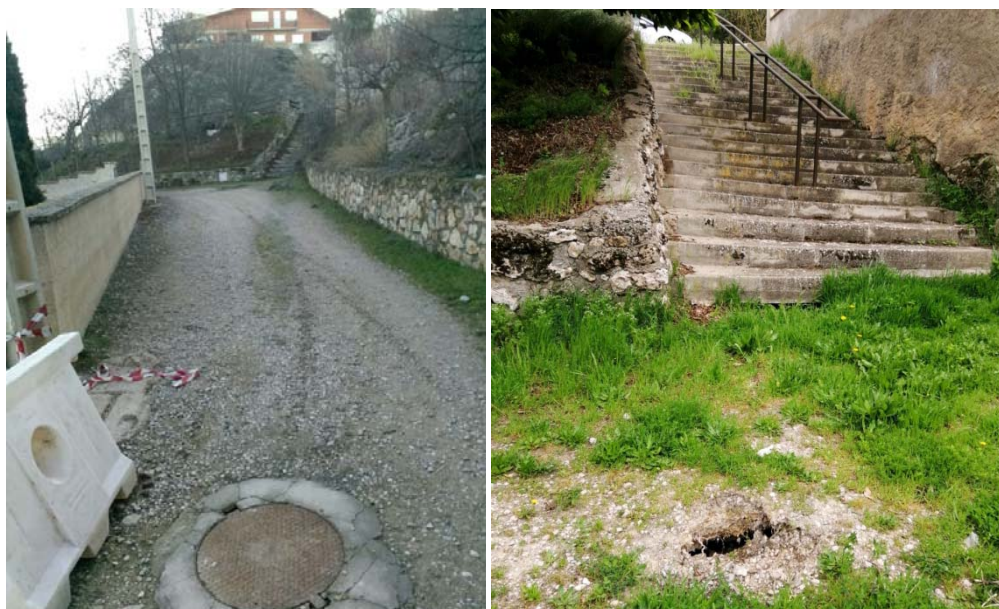
Vista 2. En primer plano pozo B. Al fondo derecha está la escalera por la que transcurre el colector. En la parte inferior se aprecia otro socavón.
